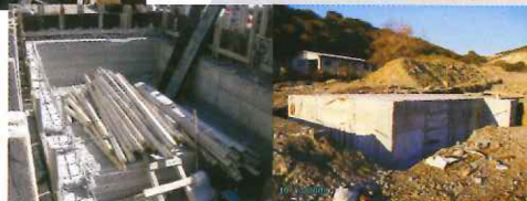
ΚΑΤΑΣΚΕΥΗ ΔΟΚΩΝ ΦΟΡΕΑ ΓΕΦΥΡΟΠΛΑΣΤΙΓΓΑΣ ΕΞ ΟΛΟΚΛΗΡΟΥ ΑΠΟ ΟΠΛΙΣΜΕΝΟ ΣΚΥΡΟΔΕΜΑ
