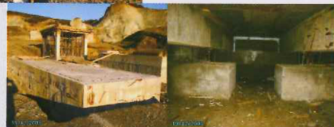
ΑΠΟΨΗ ΥΠΟΔΑΠΕΔΙΑΣ ΘΕΜΕΛΙΩΣΗΣ ΠΡΙΝ ΤΗΝ ΤΕΛΙΚΗ ΔΙΑΜΟΡΦΩΣΗ ΤΟΥ ΠΕΡΙΒΑΛΛΟΝΤΑ ΧΩΡΟΥ
