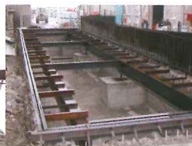
ΕΓΚΑΤΑΣΤΑΣΗ - ΣΥΝΑΡΜΟΛΟΓΗΣΗ ΧΑΛΥΒΔΙΝΟΥ ΣΚΕΛΕΤΟΥ ΦΟΡΕΑ ΑΠΟ ΕΙΔΙΚΑ ΔΙΑΜΟΡΦΩΜΕΝΟ ΓΕΡΑΝΟΦΟΡΟ ΟΧΗΜΑ
