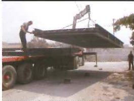
ΦΟΡΤΩΣΗ ΜΕΤΑΦΟΡΑ ΕΓΚΑΤΑΣΤΑΣΗ ΧΑΛΥΒΔΙΝΟΥ ΦΟΡΕΑ ΓΕΦΥΡΟΓΛΑΣΤΙΓΓΑΣ ΜΕ ΓΕΡΑΝΟΦΟΡΟ ΟΧΗΜΑ ΕΙΔΙΚΩΝ ΜΕΤΑΦΟΡΩΝ
