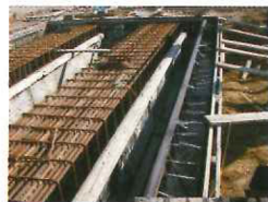
ΚΑΤΑΣΚΕΥΗ ΔΟΚΩΝ ΦΟΡΕΑ ΓΕΦΥΡΟΠΛΑΣΤΙΓΓΑΣ ΕΞ ΟΛΟΚΛΗΡΟΥ ΑΠΟ ΟΠΛΙΣΜΕΝΟ ΣΚΥΡΟΔΕΜΑ
