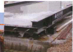
ΣΚΥΡΟΔΕΤΗΤΗ ΔΑΠΕΔΟΥ ΣΥΨΗΣ ΕΝΤΟΣ ΤΟΥ ΧΑΛΥΒΔΙΝΟΥ ΣΚΕΛΕΤΟΥ
