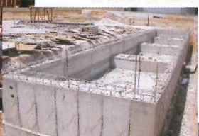
ΚΑΤΑΣΚΕΥΗ ΘΕΜΕΛΙΩΣΗΣ ΥΠΟΔΑΠΕΔΙΑΣ Γ/Φ - ΛΑΚΚΟΣ - ΕΔΡΑΣΕΙΣ
